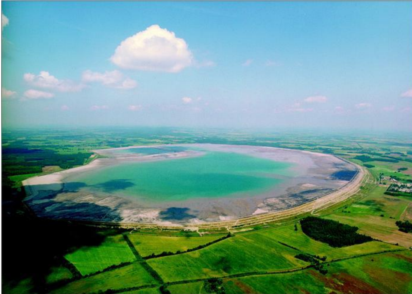
Przedpole i korona analizowanego obiektu hydrotechnicznego.
